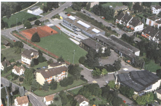
Gesamtanlage. Foto: ETH-Bibliothek, Bildarchiv
