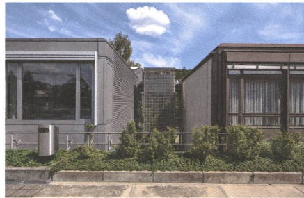
Glasbaustein-Lift zwischen den beiden Bauetappen.
