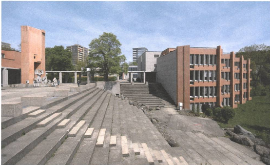
Der lachsfarbene Anstrich wird bei der laufenden Sanierung entfernt. Foto: Werner Huber
