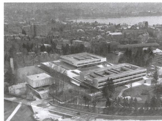
Kantonsschulen Enge und Freudenberg, Zürich, Gesamtansicht. Foto: Bildarchiv ETH-Bibliothek
