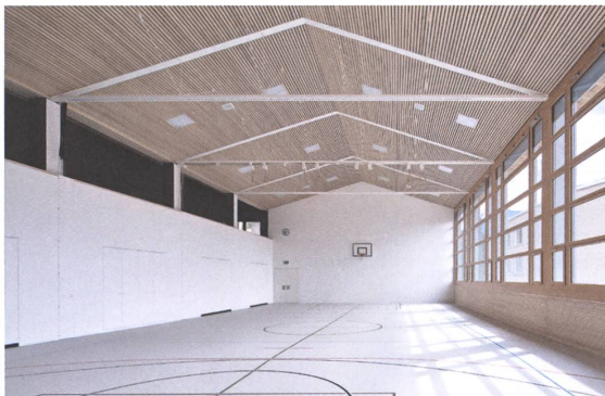
Die alte Halle neu mit einem ins Haus gezogenen, eigenen Satteldach im Holzkleid.
