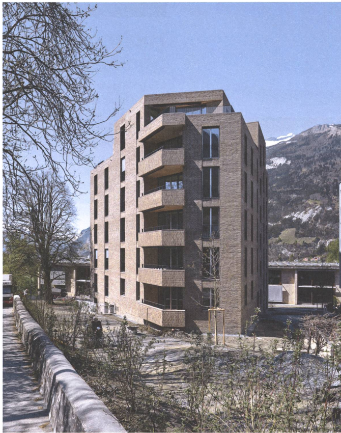
Neue Alterswohnungen in Chur in einem dichten Ensemble mit Weitsicht.
