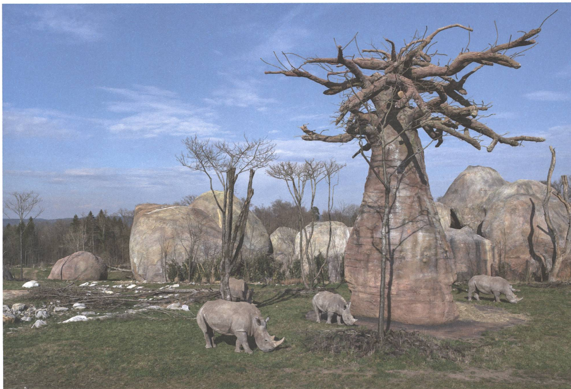
Dieser gegen zwanzig Meter hohe Baobab-Baum vor den Kopjefelsen spendet Schatten und Futter. Er besteht aus einer komplexen Stahlkonstruktion mit Betonüberzug.
