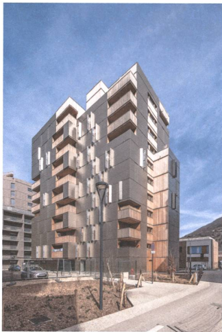
3 Wohnhochhaus Le Solaris, Grenoble (F).
