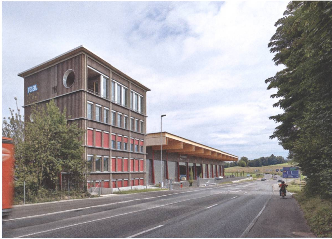
Der 120 Meter lange Recyclinghof in Emmen steht zwischen Strasse und Autobahn.
