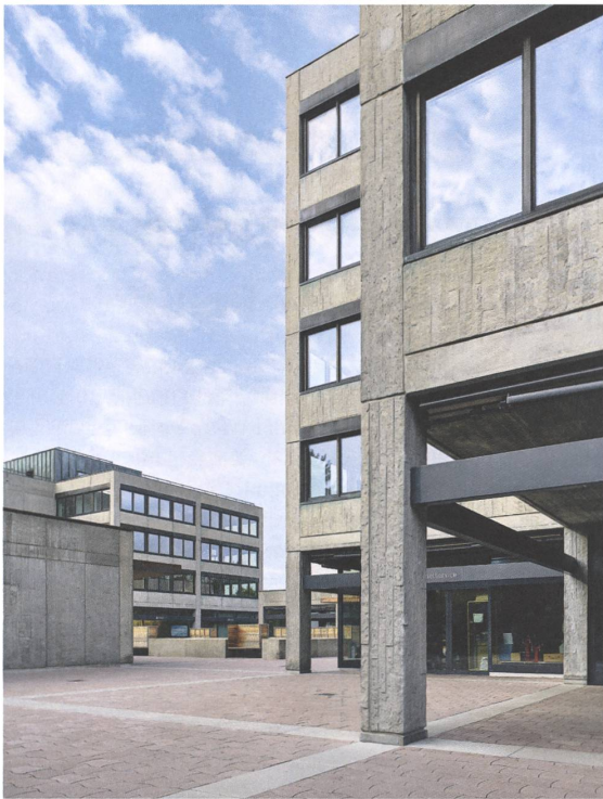
Präzise Kuben aus Beton, Fensterprofile aus Kupfer und ein Teppich aus Betonbändern und rötlichen Verbundsteinen: Nach seiner Sanierung zeigt sich das fünfzigjährige Zentrum Witikon in alter Frische.
