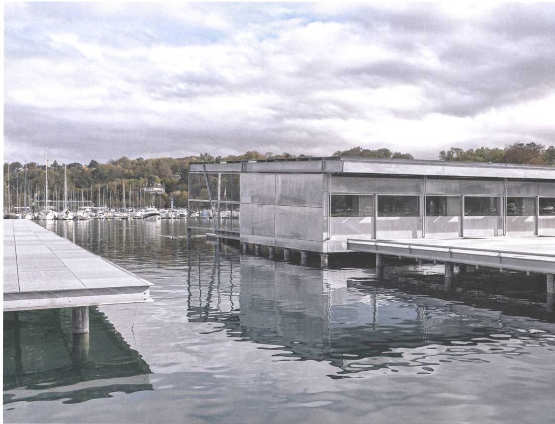
Der Charakter des verzinkten Blechs ändert sich mit dem Wechsel der Witterung und der Tageszeiten.
