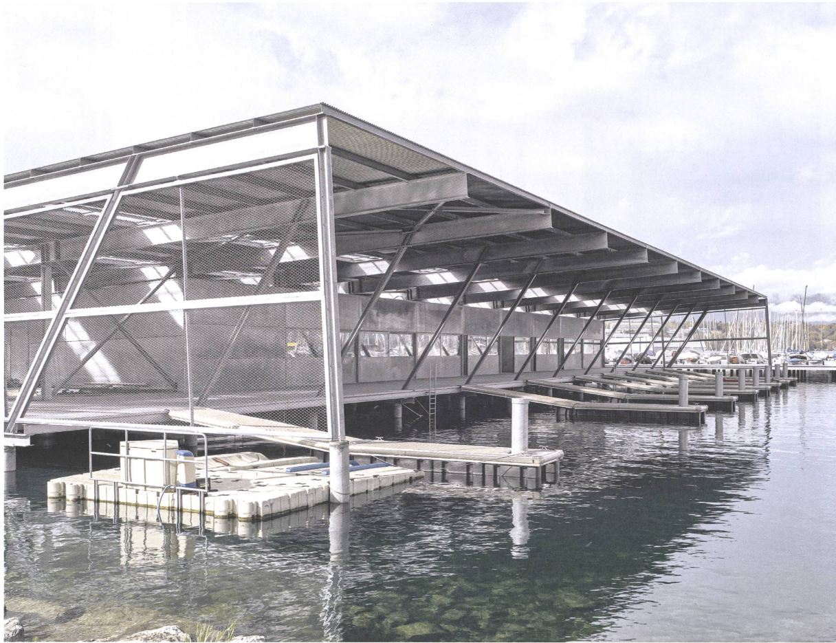
Pfahl- und Stahlbau in Genf: Ein weit auskragendes Vordach schützt die Fischer, die ihren Fang an Land bringen.
