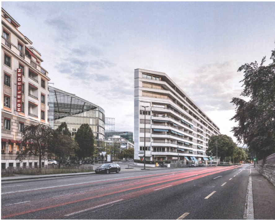
Drei zusätzliche Geschosse geben der Wohnhausscheibe an der Rue de Lausanne in Genf einen prägnanten Auftritt.
