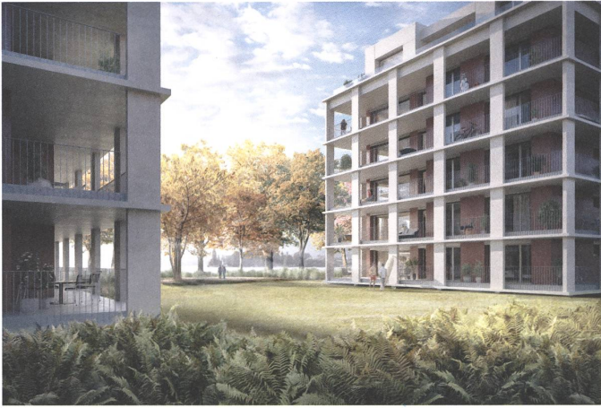
Caruso St John, Arbon: schwebende Bodenplatte auf abgesenktem Terrain.
