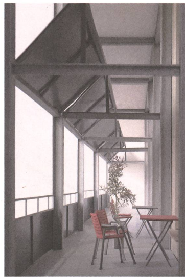
Strom erzeugen die schräg gestellten Brise-soleil und die Balkonbrüstungen.
