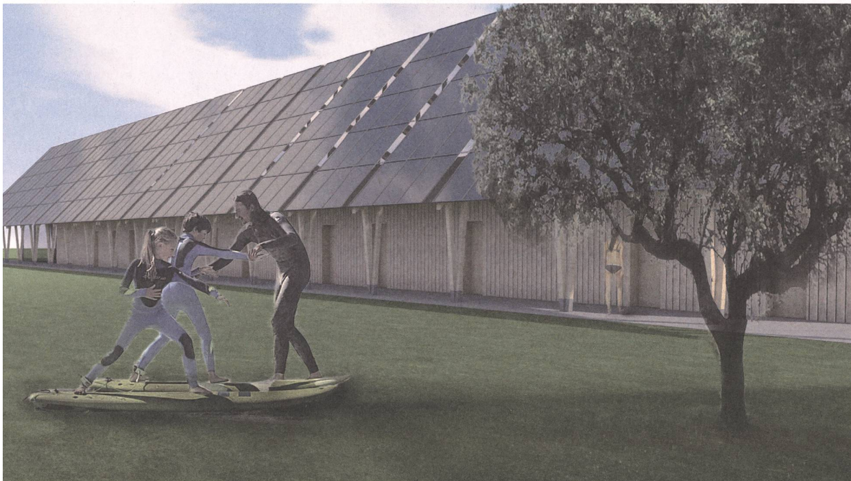
Sonnenstrom als Zeichen: Die filigrane Dachkonstruktion trägt eine Solaranlage als Dachhaut.
