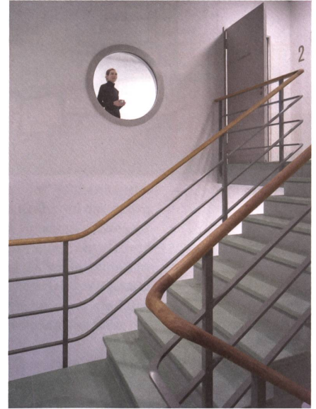
Die neue Innentreppe führt der ehemaligen Fassade entlang.
