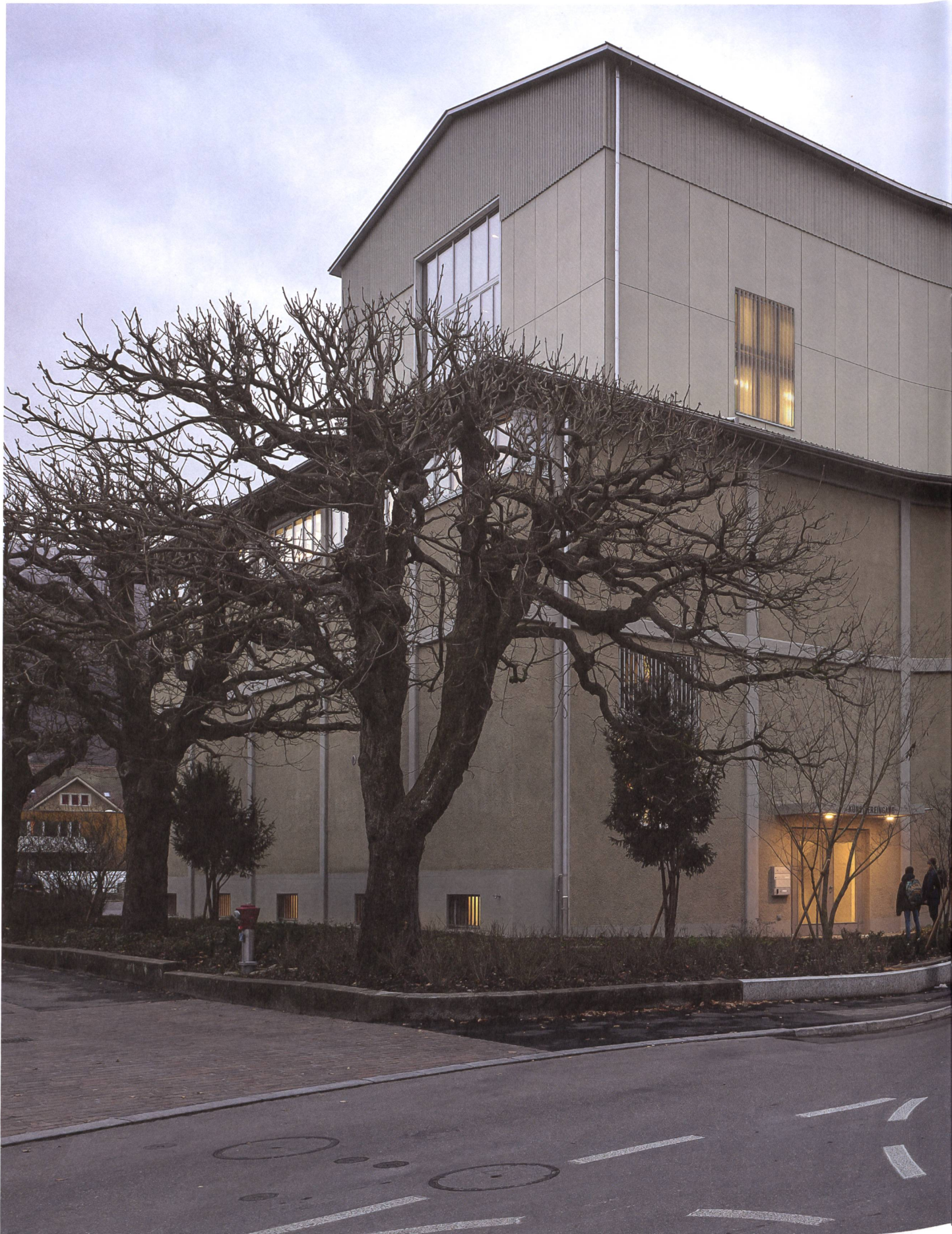
Die rückwärtige Erweiterung von Theatergebäude und Bühnenturm ist nahtlos mit dem bestehenden Gebäude verschliffen.
