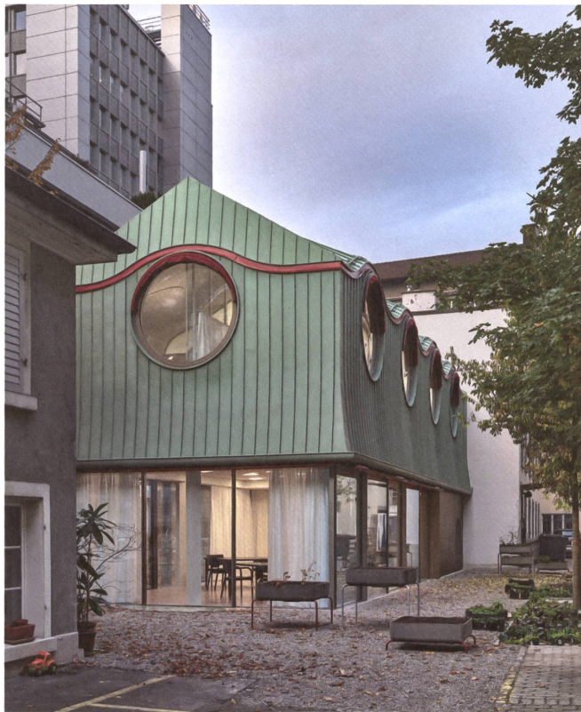
Neue Offenheit: Mit dem Hofgebäude erhält das Alterszentrum attraktive Gemeinschaftsräume und das Quartier eine Oase.
