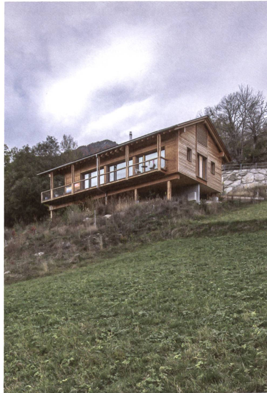
Nach Süden ausgerichtet braucht das Haus keine Heizung.
