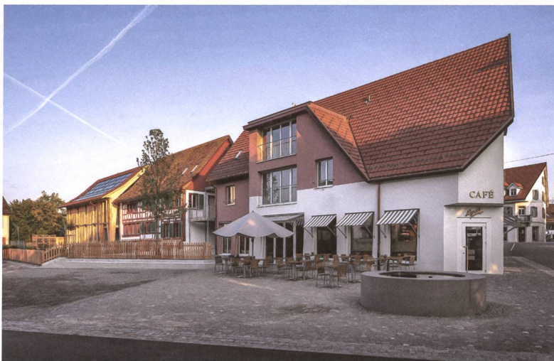
Zwei Neubauten flankieren den 200 Jahre alten, herausgeputzten Riegelbau in Winterthur.
