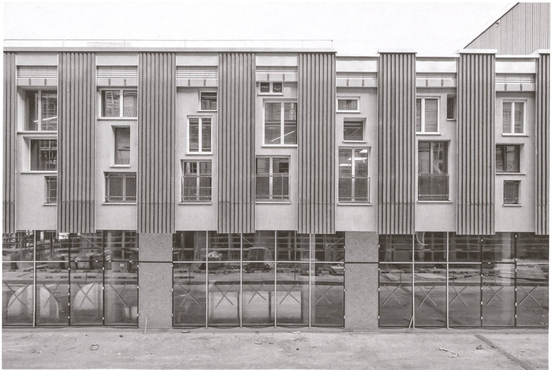
Kultur- und Gewerbehäuser Lysbüchel, Basel: Zwischen dem Rhythmus alter Trapezbleche sitzen 200 Lagerfenster in den aus Abbruchholz geleimten Rahmen. | Immeuble culturel et commercial Lysbüchel, Bâle: 200 fenêtres d'entrepôt sont insérées dans le cadre collé en bois de démolition et cassent le rythme des anciennes tôles trapézoïdales. Foto | Photo: Martin Zeller
