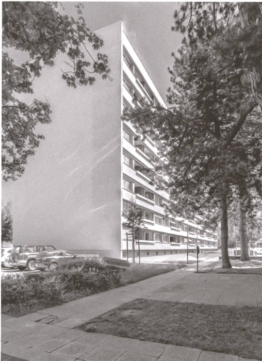
Tscharnergut, Bern: Nur ein Verputzstreifen verrät, dass eine Raumschicht die Sechzigerjahresiedlung erweitert. | Tscharnergut, Berne: Seule une bande de crépi révèle qu'il y a une extension du complexe résidentiel des années soixante.
