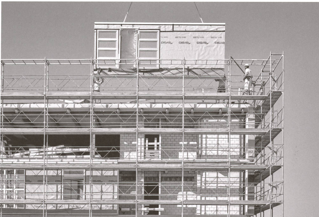
Aufstockung K118, Winterthur: Das Pilotprojekt besteht zu fast sechzig Prozent aus alten Bauteilen und verursacht nur halb so viele Emissionen wie der SIA-Effizienzpfad Energie verlangt. | Surélévation K118, Winterthour: Le projet pilote est constitué de près de soixante pour-cent d'anciens éléments de construction et ne cause que la moitié des valeurs-cibles des émissions requises par la voie SIA vers l'efficacité énergétique. Foto | Photo: Martin Zeller
