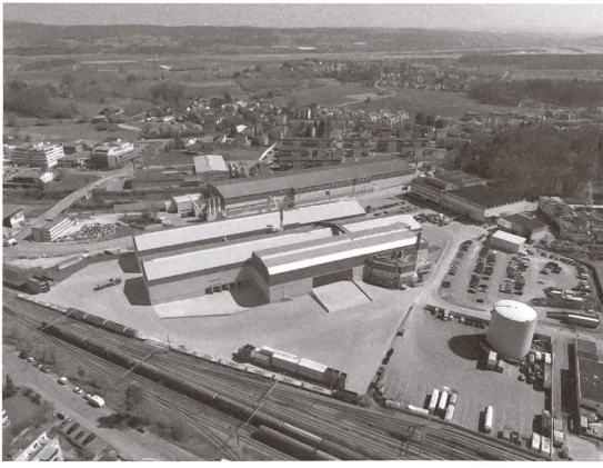
Eberhard baut in Oberglatt eine neue Aufbereitungsanlage. | Eberhard construit à Oberglatt une nouvelle installation de traitement. Renderings | Rendus: Eberhard
