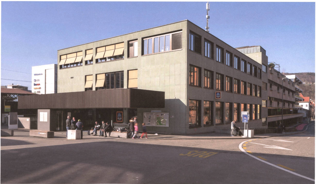
Das Vordach erhielt einen voluminösen Rand aus dunklem Trapezblech und bedrängt den Moser-Bau. Foto: Susanne Stauss
