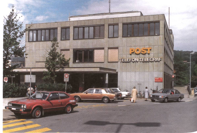
Mitte der 1980er-Jahre ist der leichte Vorbau einem Betondach mit Liftturm gewichen. Foto: Werner Huber
