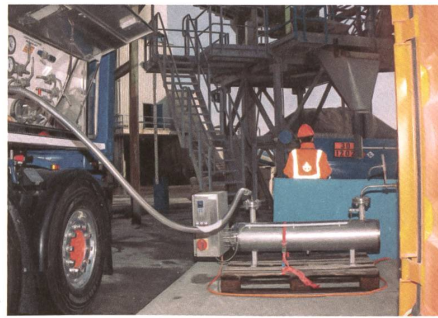
Das flüssige CO 2 wird in Gasform umgewandelt, bevor es in den Container mit dem Betonbruch gelangt.
