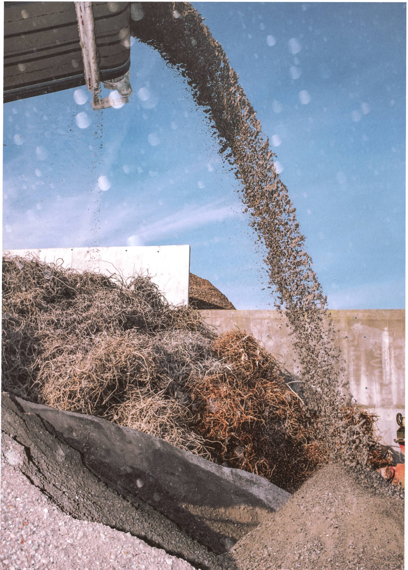
Im Recyclingwerk der Firma Kibag in Regensdorf wird Betonabbruch zerkleinert, um daraus Recyclingbeton herzustellen.
