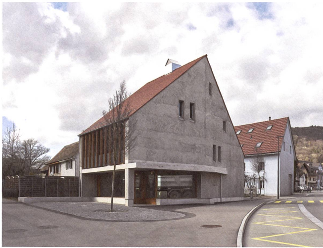
Unter dem schmalen Vordach liegen ein Ladeneingang und eine Busstation.
