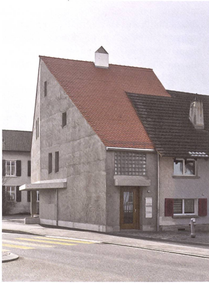
Neu-vertraut: Das steile, doppelgedeckte Dach, die schmalen Fenster und Vordächer erinnern an die ortsüblichen Trotten. Fotos: Schaub Stierli
