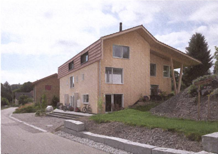
«Dreiflofenhaus» in Wahlendorf bei Bern: Zur Strasse hin schafft es einen Vorplatz, zum Garten eine Veranda.
