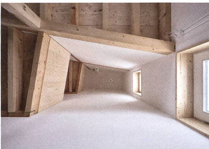
Schlicht und sparsam: OSB-Platten, Fichtenriemen, Unterlagsböden und sichtbare Deckenbalken.
