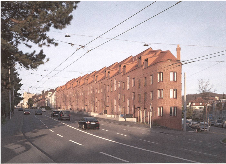
Die Wohnmauer aus 150 000 Ziegeln am Rosengarten in Zürich.
