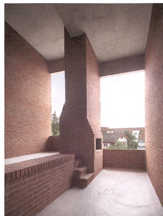
... und ein grosser Balkon aussen.
