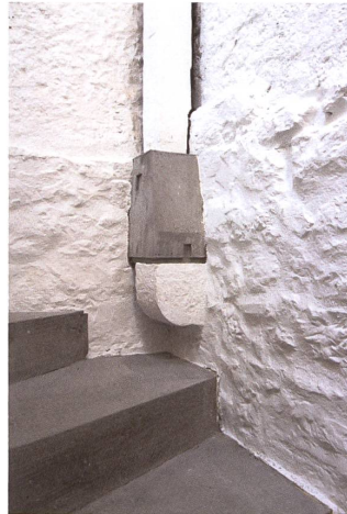
Lesbare Brüche: Wo einst die Decke war und nun die Treppe liegt, trägt ein Auflager den alten Holzpfosten.
