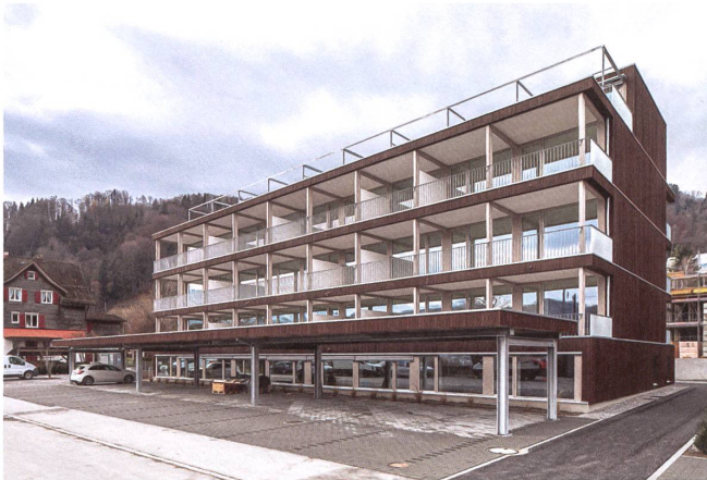
Pragmatisch präsentiert sich das Haus zur Strasse.
