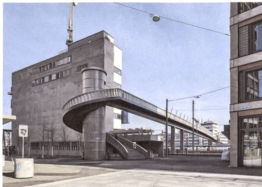
Die Rundtreppen bei den Aufgängen sparen Platz.
