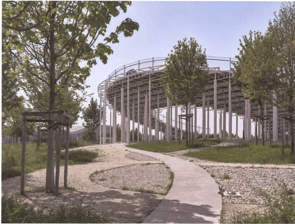
Die tellerförmige Sitztribüne Agora spendet Schatten und gibt auf der anderen Seite den Blick auf den See frei.
