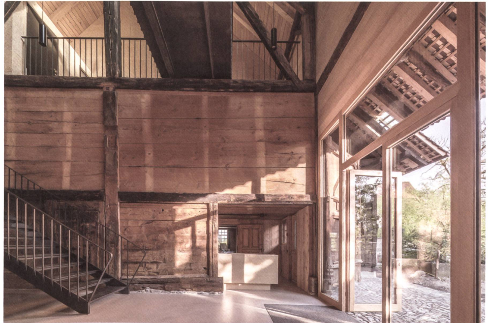
Die Konstruktion bis zum First erleben: Zum Weg hin verglast, von Zwischendecken befreit und mit einer stählernen Treppe ist das einstige Tenn heute ein Ort, wo man eintritt und sich trifft. Von hier erreicht man die Musiksäle.
