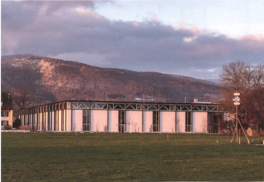
Das umlaufende Fensterband der Produktionsstätte in Härkingen macht das innen liegende Fachwerk sichtbar.
