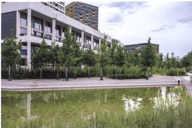
Bei der Überbauung Wolkenwerk in Zürich wächst «stadtklimafestes» Gehölz heran.
