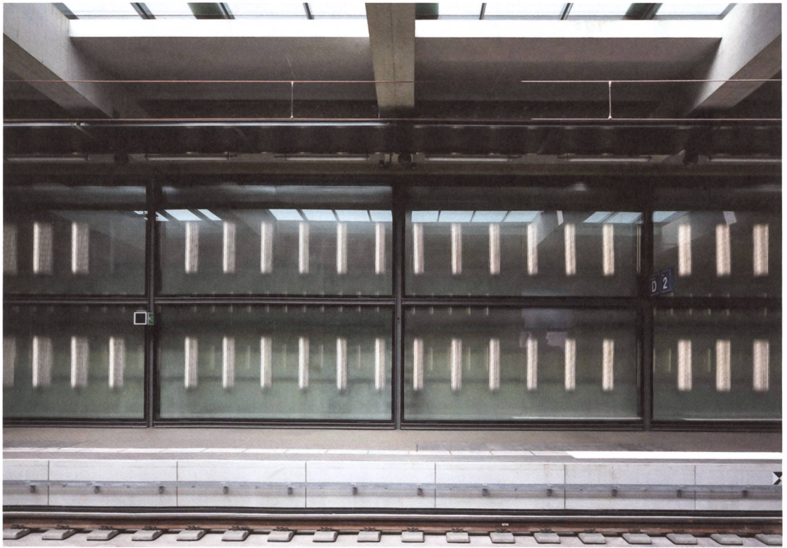
Chêne-Bourg: Im nur knapp unter der Erde liegenden Bahnhof stehen Tages- und Kunstlicht im Wettstreit. Foto: Werner Huber
