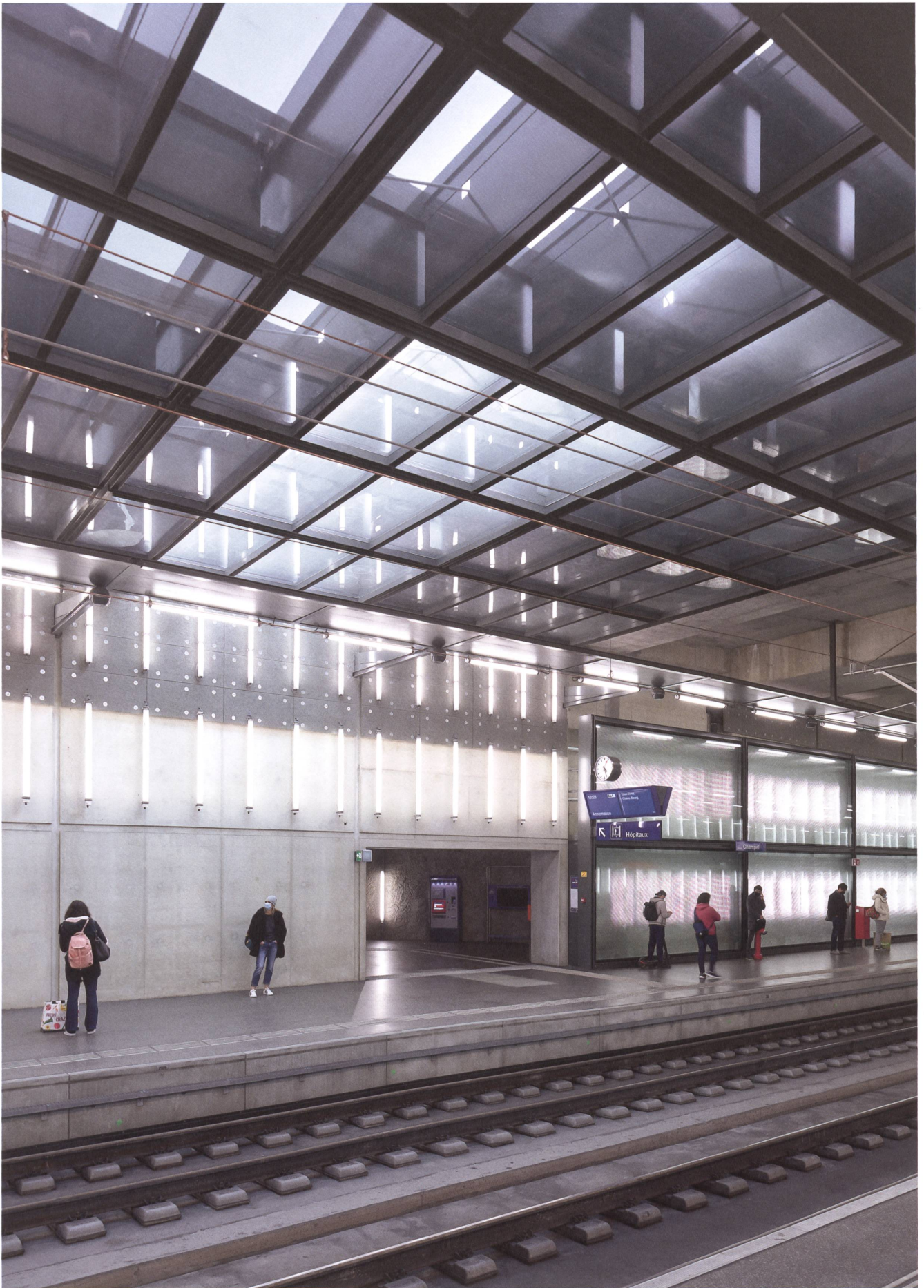
Genève-Champel: Tageslicht, Leuchten auf Beton und hinterleuchtete Glasbausteine erzeugen eine lichte Atmosphäre im unterirdischen Bahnhof.
