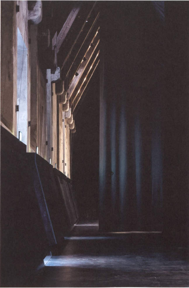
Die schräge Wandverschalung erinnert an den Anreitschutz von einst.
