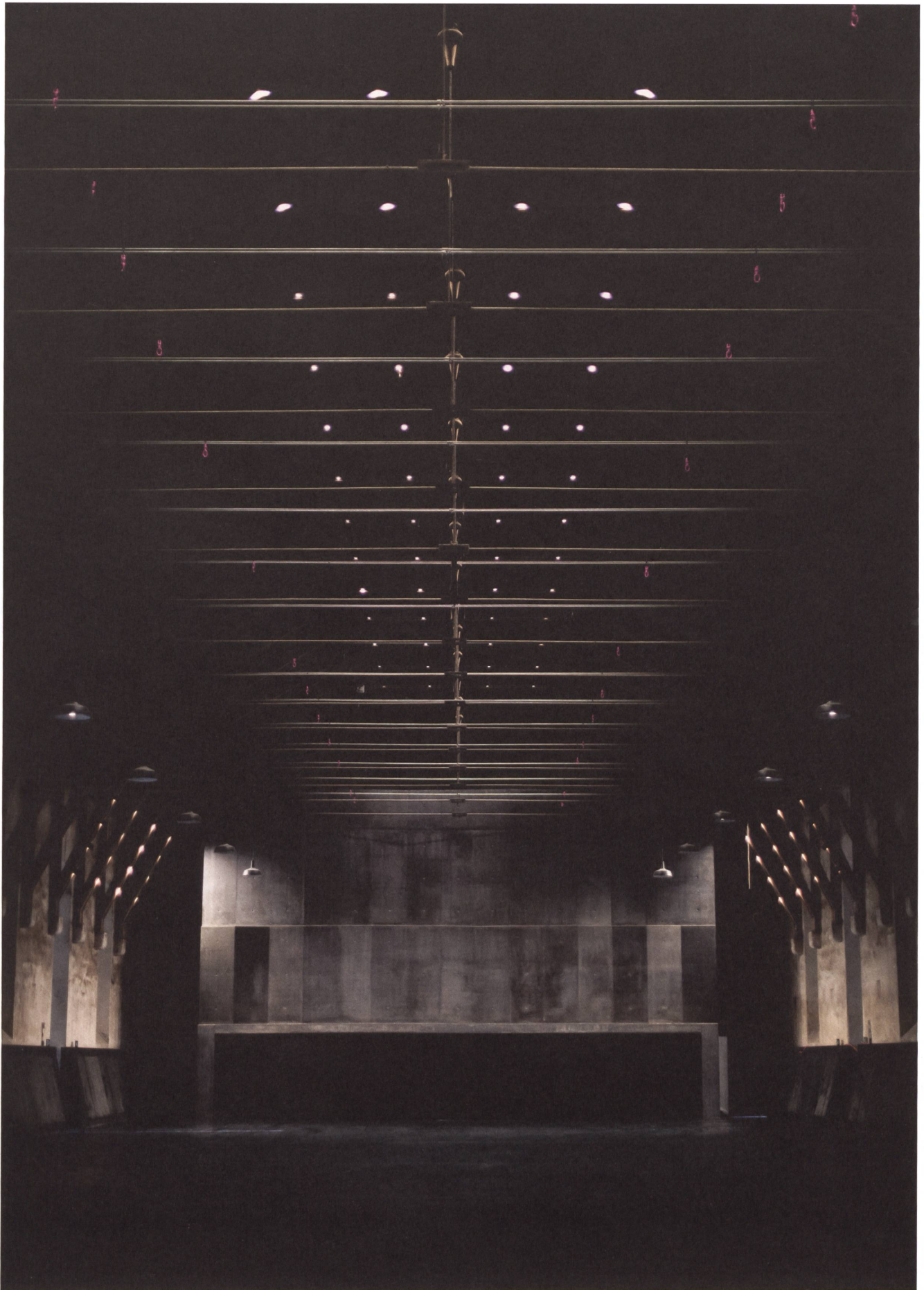
Einraumerlebnis: Das markante Gebälk prägt die Alte Reithalle in Aarau so wie früher, Betonkuben am Rand nehmen die neuen Räume auf.
