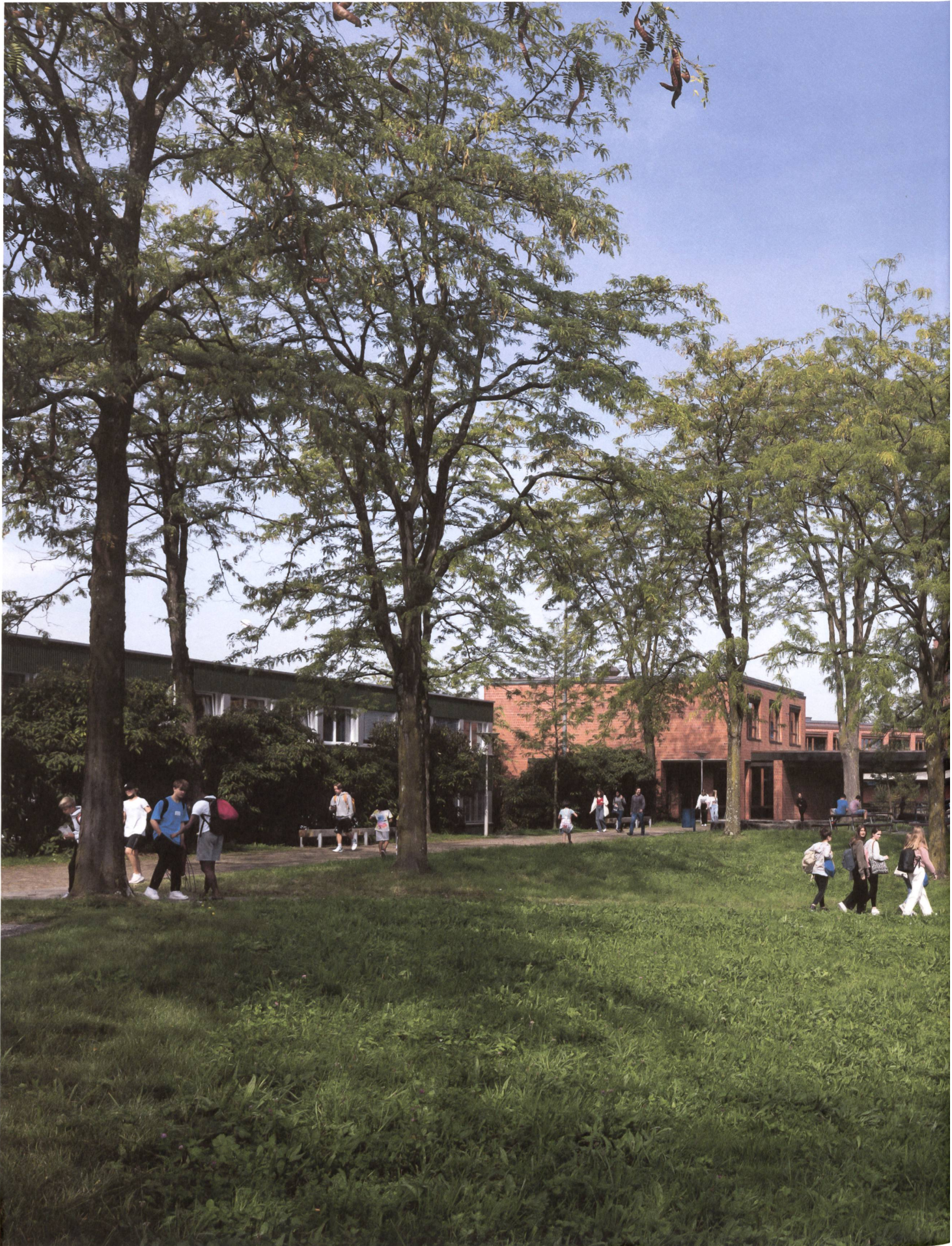
Ein typisches Ensemble der frühen 1970er-Jahre – oder doch nicht? Das oberste Geschoss ist neu, und die blauen Storen zieren das Haus erst seit der Sanierung. Foto: Christian Senti
