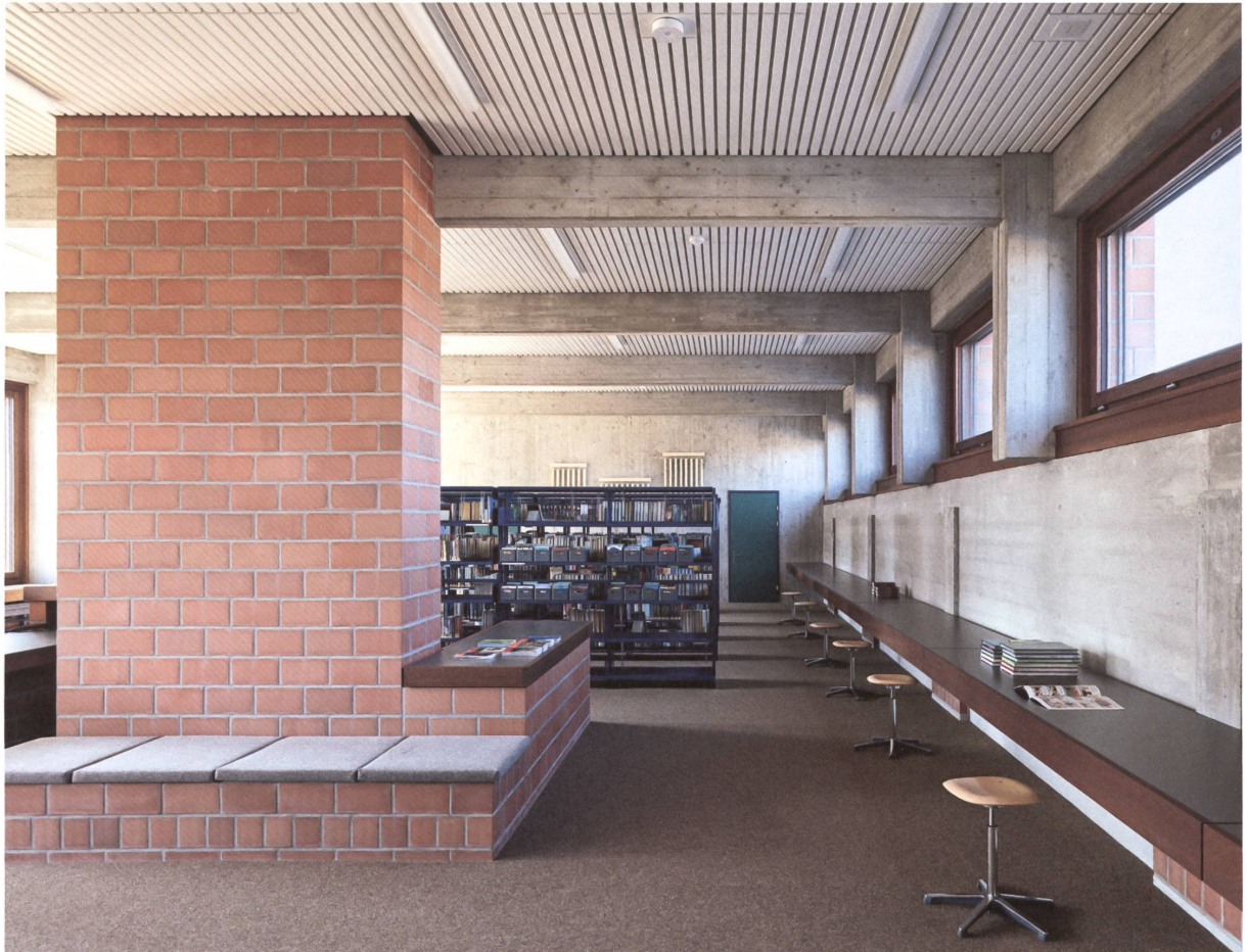
In der neuen Bibliothek wurde ein bestehender Schacht verlängert und zu einer Sitzgruppe ausgebaut.
