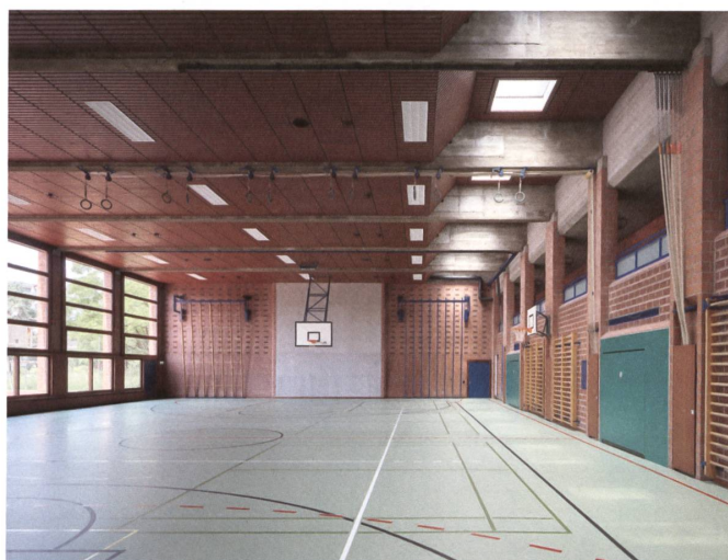
Neue Oberlichter erhellen die Turnhalle, hinter dem ehemaligen Oblichtband befindet sich nun die Bibliothek. Eine Betonscheibe schützt vor Erdbebenkräften.
