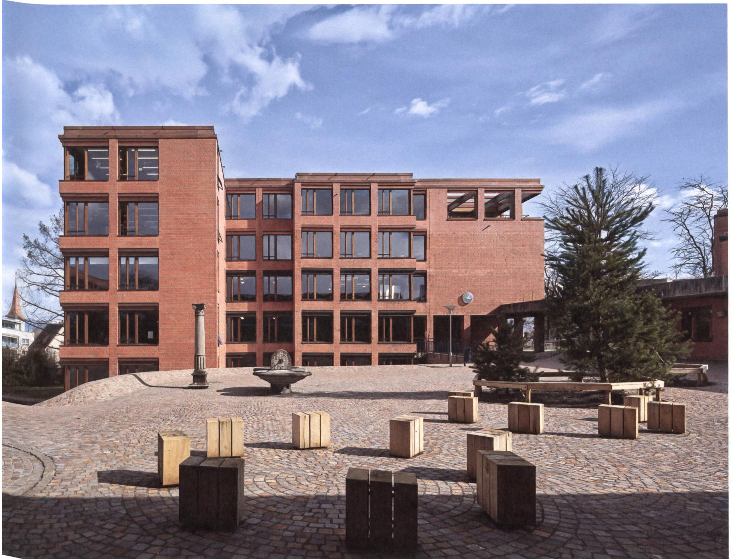
Das zusätzliche Geschoss und der neue Gebäudeflügel stärken die räumliche Kraft des Pausenhofs.
