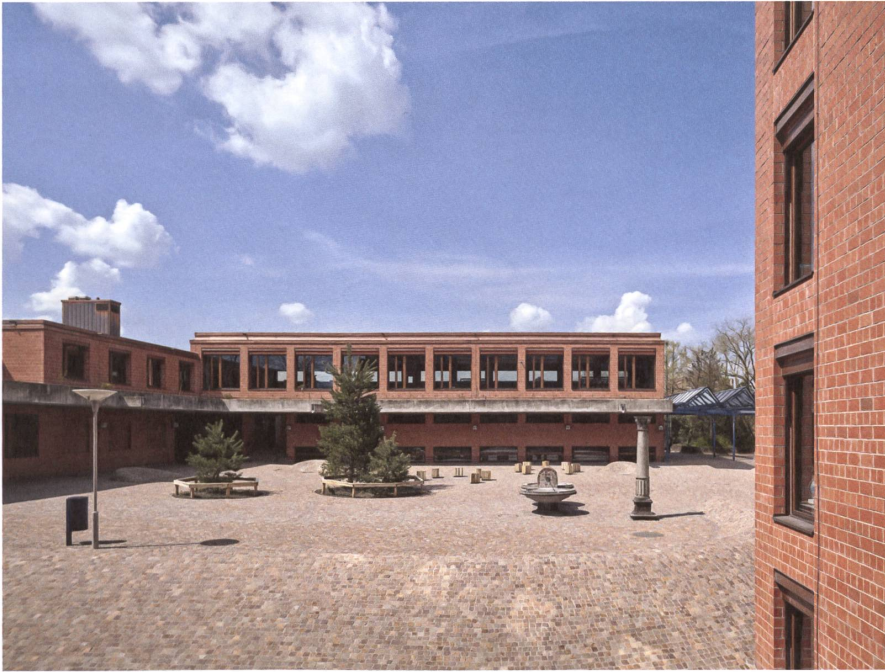
Turnhallen- und Aulatrakt: Auf den Garderoben sitzt die neue Bibliothek.
