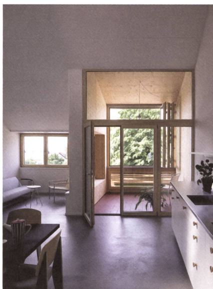
Die Gaube birgt im Inneren einen Wintergarten und sorgt für reichlich Tageslicht in den Küchen.
