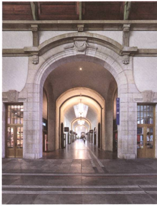
Der Korridor im Westflügel des Bahnhofs hat seine ursprüngliche Höhe zurückerhalten.
