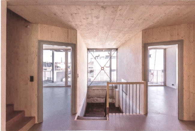
Massivholzplatten aus Tanne verkleiden Wände und Decken. Weiss pigmentierte Seife macht das Holz wetterfest, ohne dessen Poren zu verschliessen.
