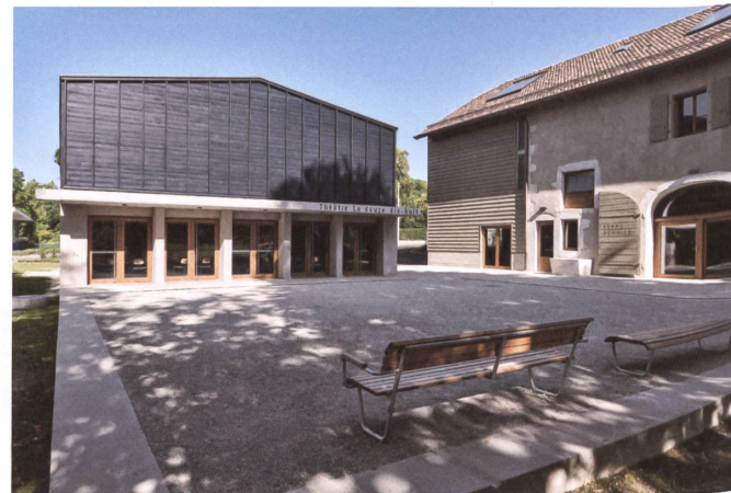
9 Le théâtre reprend le langage de l'ancien bâtiment d'exploitation.
