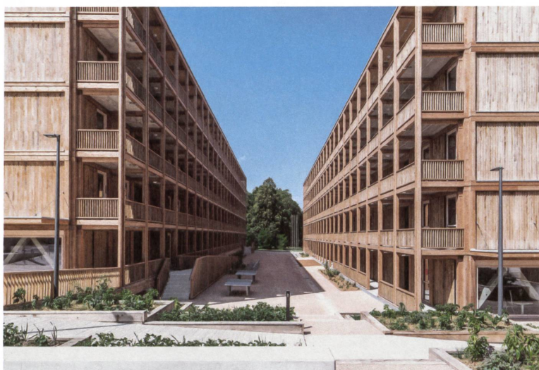
Les deux barres du centre d'hébergement forment une cour intérieure.
