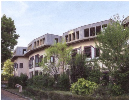
12 Vers l'extérieur, la surélévation évoque une couronne.
