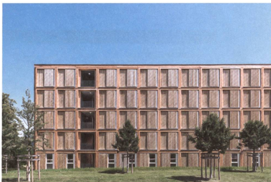
Les modules rythment les façades.
