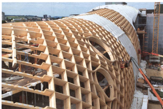
Die Dachkonstruktion besteht aus 4600 unterschiedlichen Elementen.
