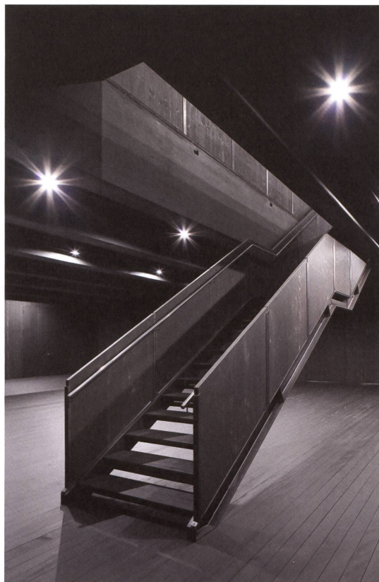
23 Die Decken zwischen manchen Balken können entfernt werden und die Treppen verschoben werden.
