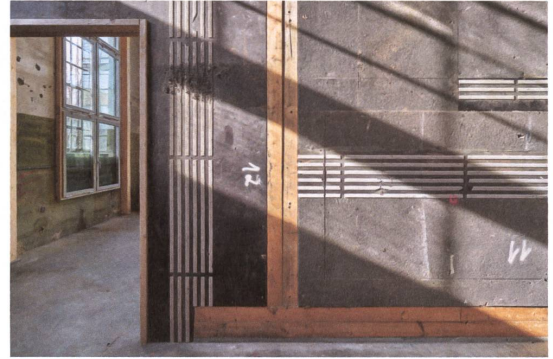
26 Die Wandkonstruktion stammt von einem provisorischen Bahnübergang in Winterthur.
