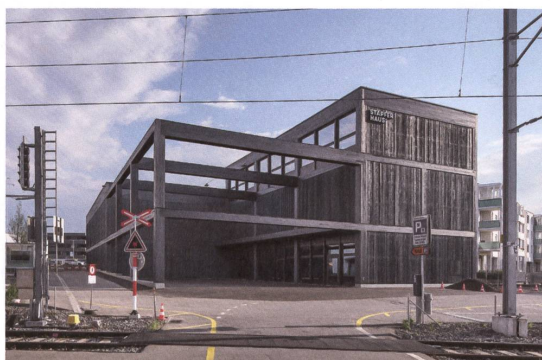
23 Die Fassade zeigt Struktur und Füllung.
