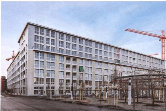
24 Von aussen sieht man dem «Krokodil» die Holzkonstruktion nicht an.
