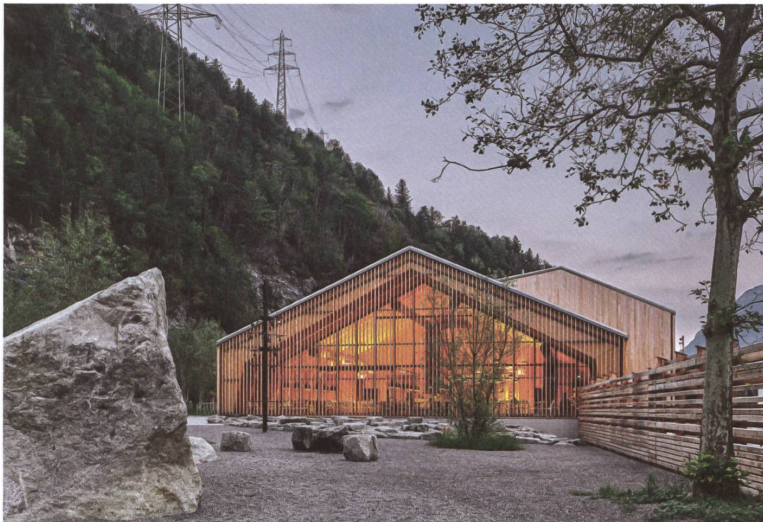
30 Die Bauten der Autobahnreststätte Erstfeld erinnern an Scheunen.
