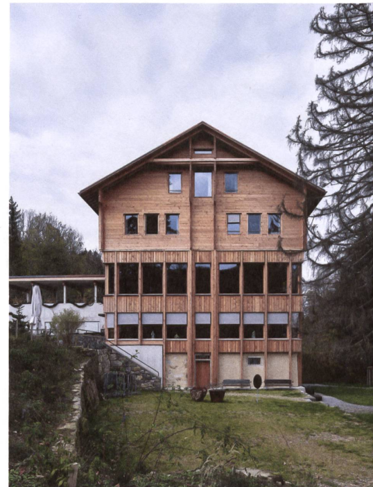
33 Das Gasthaus Hergiswald schichtet verschiedene Konstruktionsweisen übereinander.
