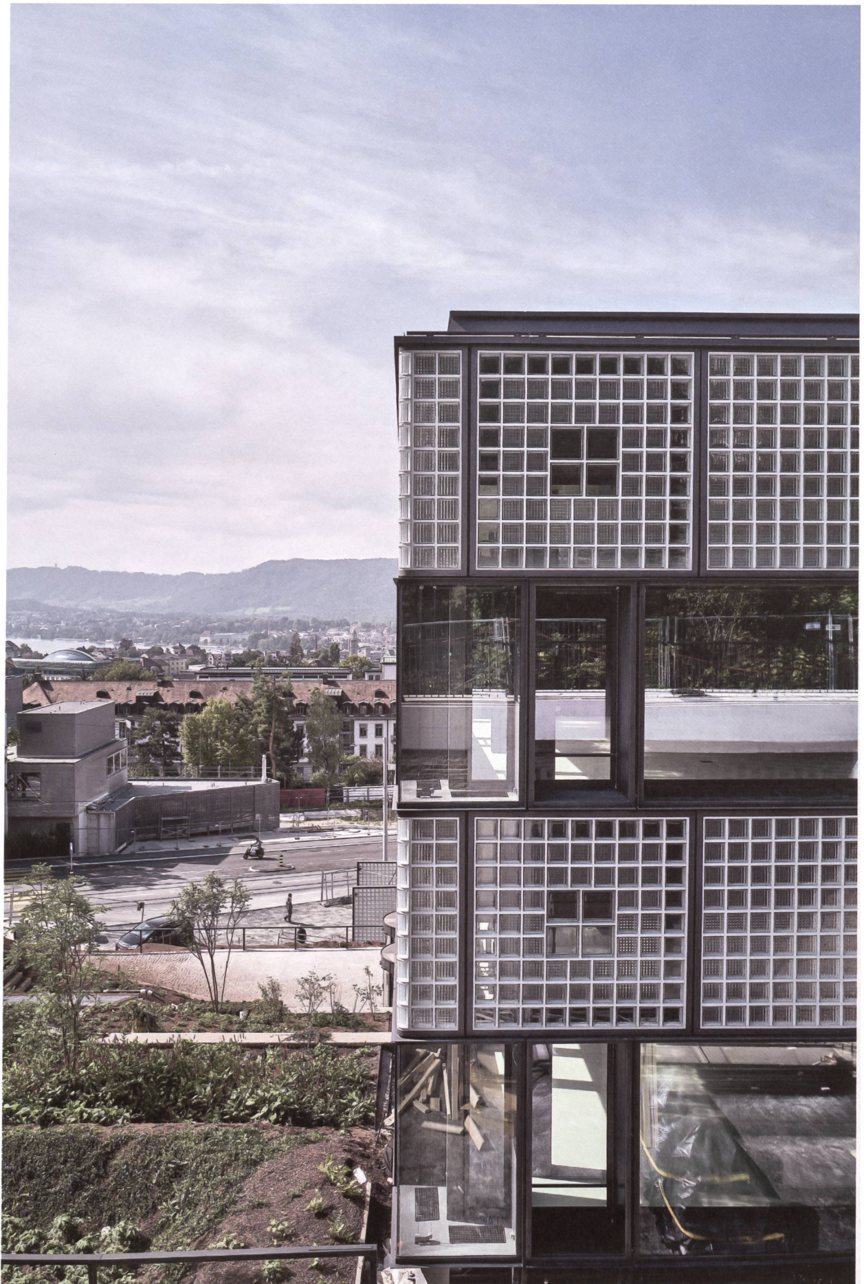
Das Relief, unterschiedlich grosse Glasbausteine und balancierte Proportionen machen die vermeintlich harte Fassade des Zürcher Laborbaus leicht und lebendig.
