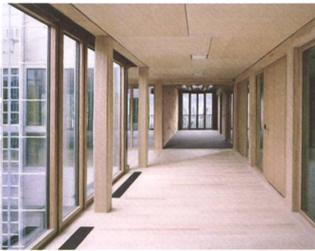
Die Holzstützen sind leicht konisch geformt.
