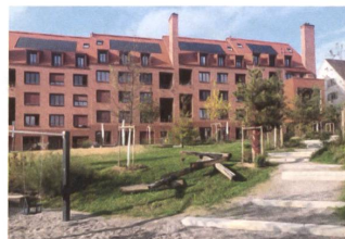
Areal Rosengarten, Zürich Kolb, Zürich
