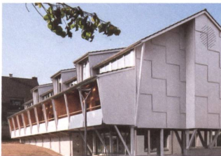
Alterswohnungen, Brütten ZH Roider Giovanoli, Zürich
