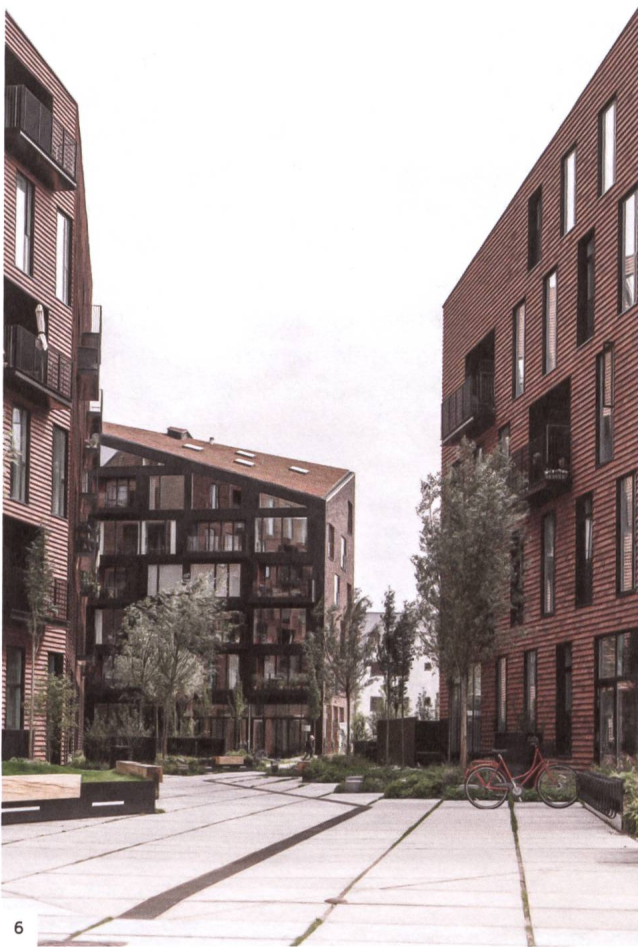
6 Anstoss zur Entwicklung des extrudierten Fassadenziegels gab der Krøyers Plads in Kopenhagen, eine Brache an bester Wasserlage zwischen Königlichem Schauspielhaus und Freistaat Christiania. Fotos: Rasmus Hjortshøj
