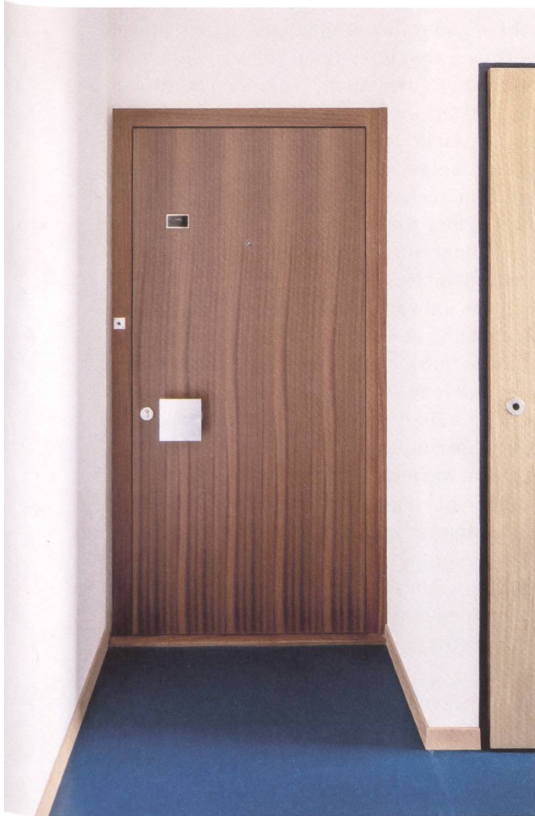
Schlichte Treppenhäuser: Die Wohnungstüren und die Linoleumböden sind neu, orientieren sich aber am Original aus den 1960er-Jahren.
