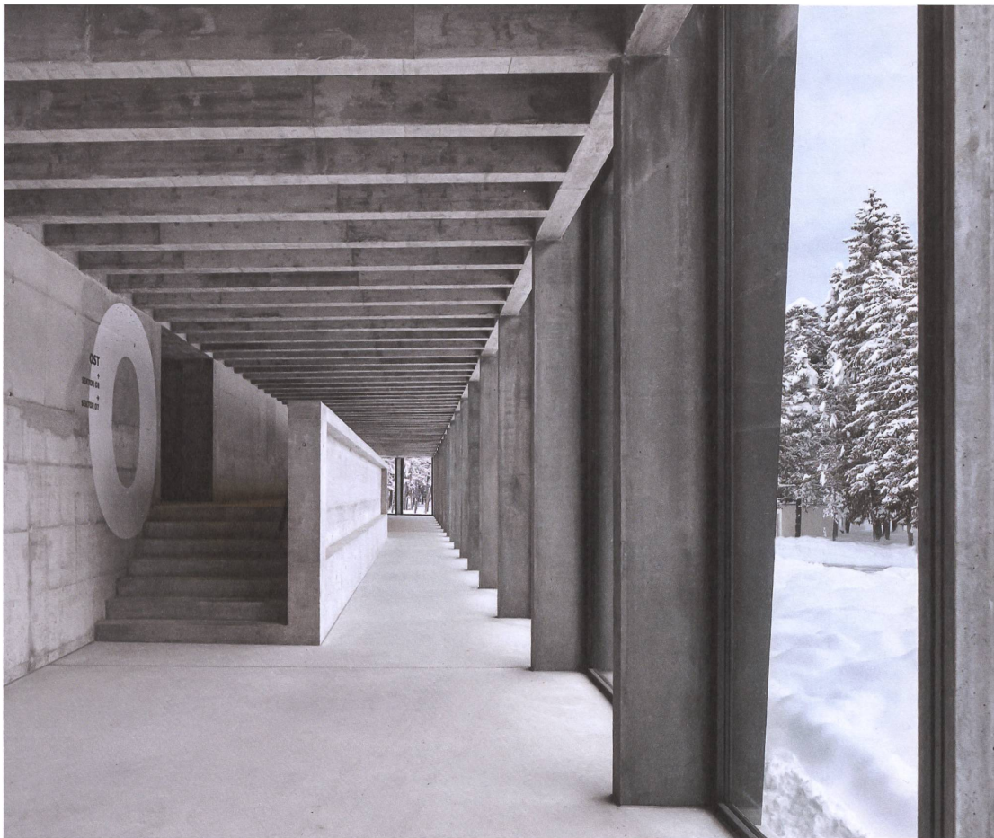
Der betonierte Vorbau und Umgang im Innern des Stadions ist so dimensioniert, dass 6500 Menschen im Notfall schnell fliehen könnten.
