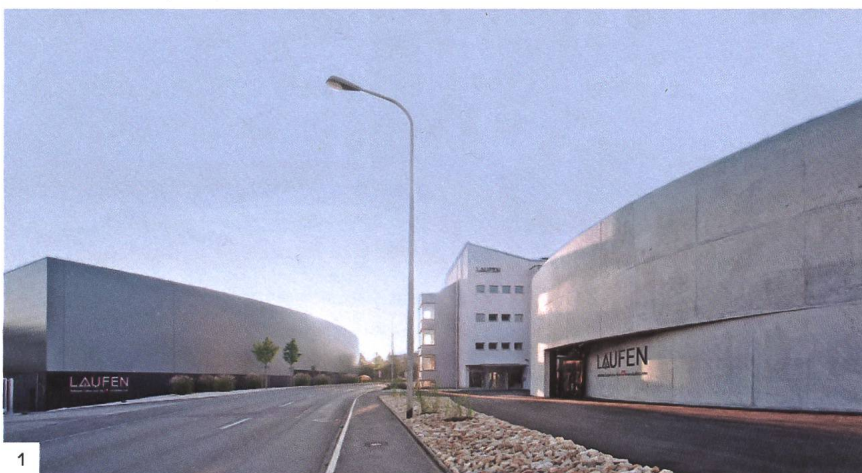
1 Das Badkompetenzzentrum von Laufen vereint die Armaturen- und Keramikproduktion, die Ausstellung «Laufen Forum», das Verwaltungsgebäude und das Trainingscenter an einem Standort.
