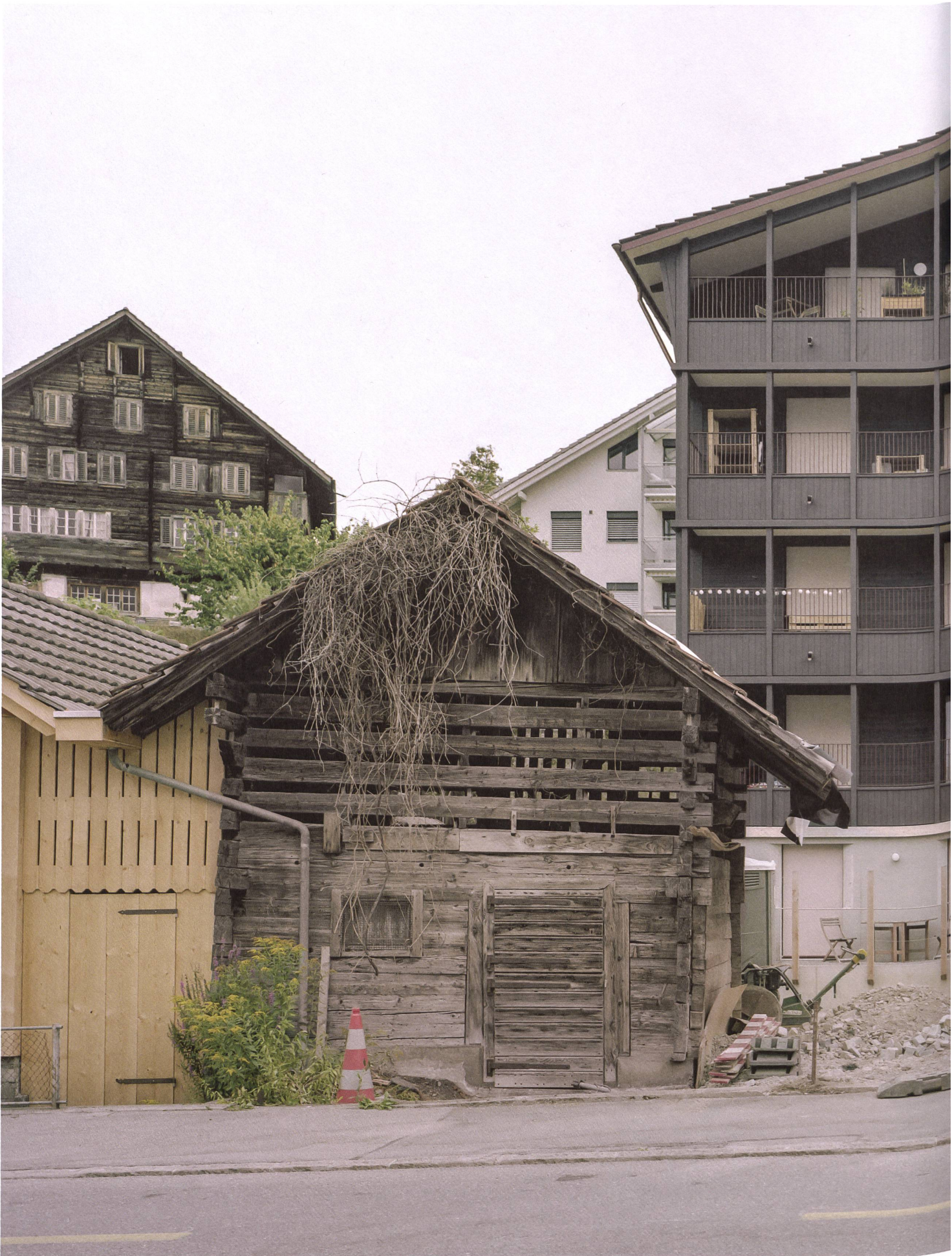
Nach der sanften Renovation des kleinen Schuppens neben dem Altbau ist etwa die Einrichtung eines Veloraums oder einer kleinen Werkstatt möglich.
