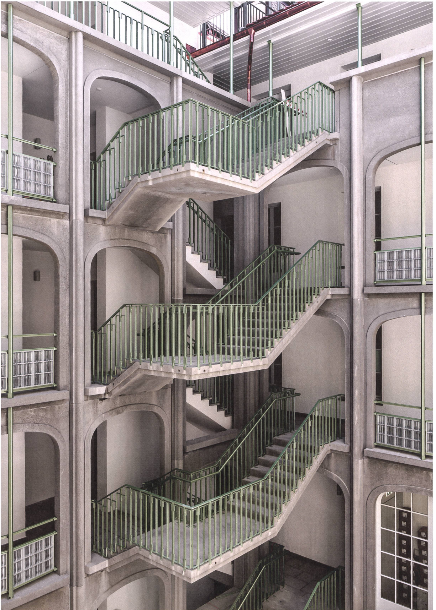
Im Hof verbindet eine offene Treppe die Geschosse und sorgt für Begegnung und Belebung.
