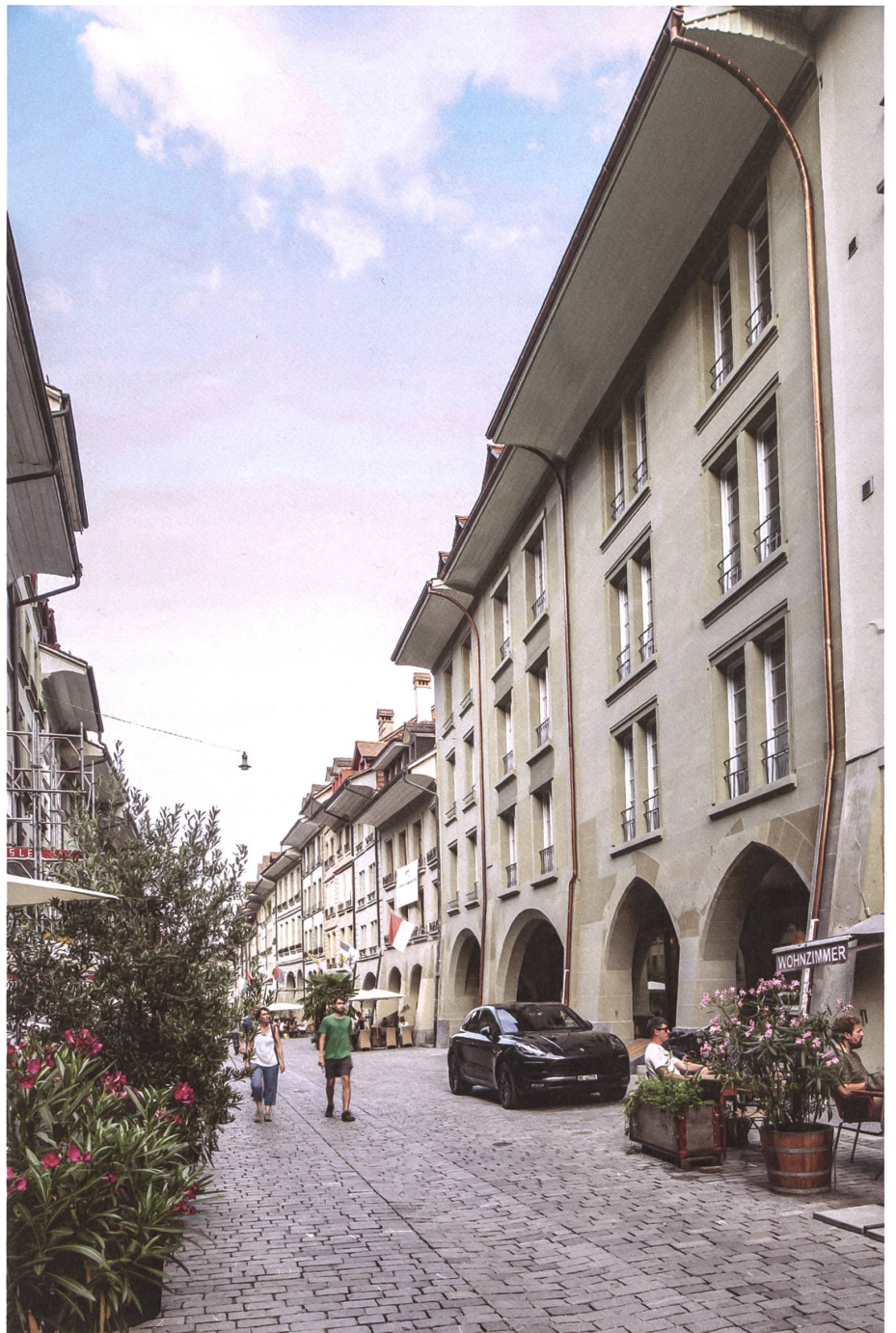
Drei neue Fassadenabschnitte vervollständigen das Bild an der Rathausgasse.
