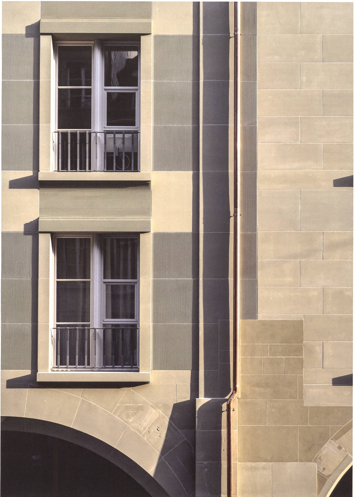
An den neuen Sandsteinfassaden an der Rathausgasse werden die Frässpuren zum Ornament.
