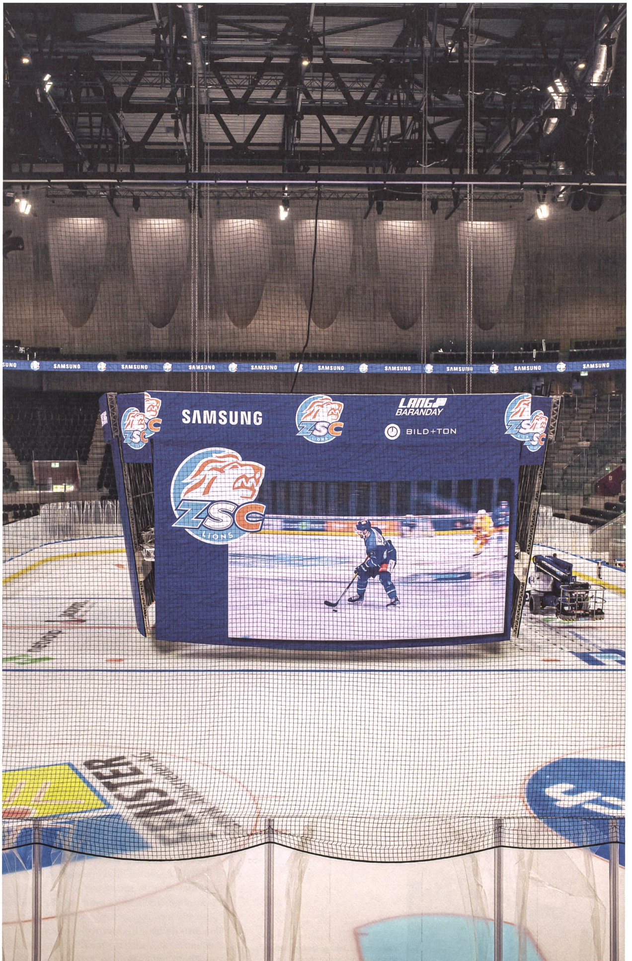
Die Stahlkonstruktion des Stadionsdachs trägt viel Technik, unter anderem einen «LED-Cube», der vierseitig Livebilder, Werbung und den Spielstand anzeigt.
