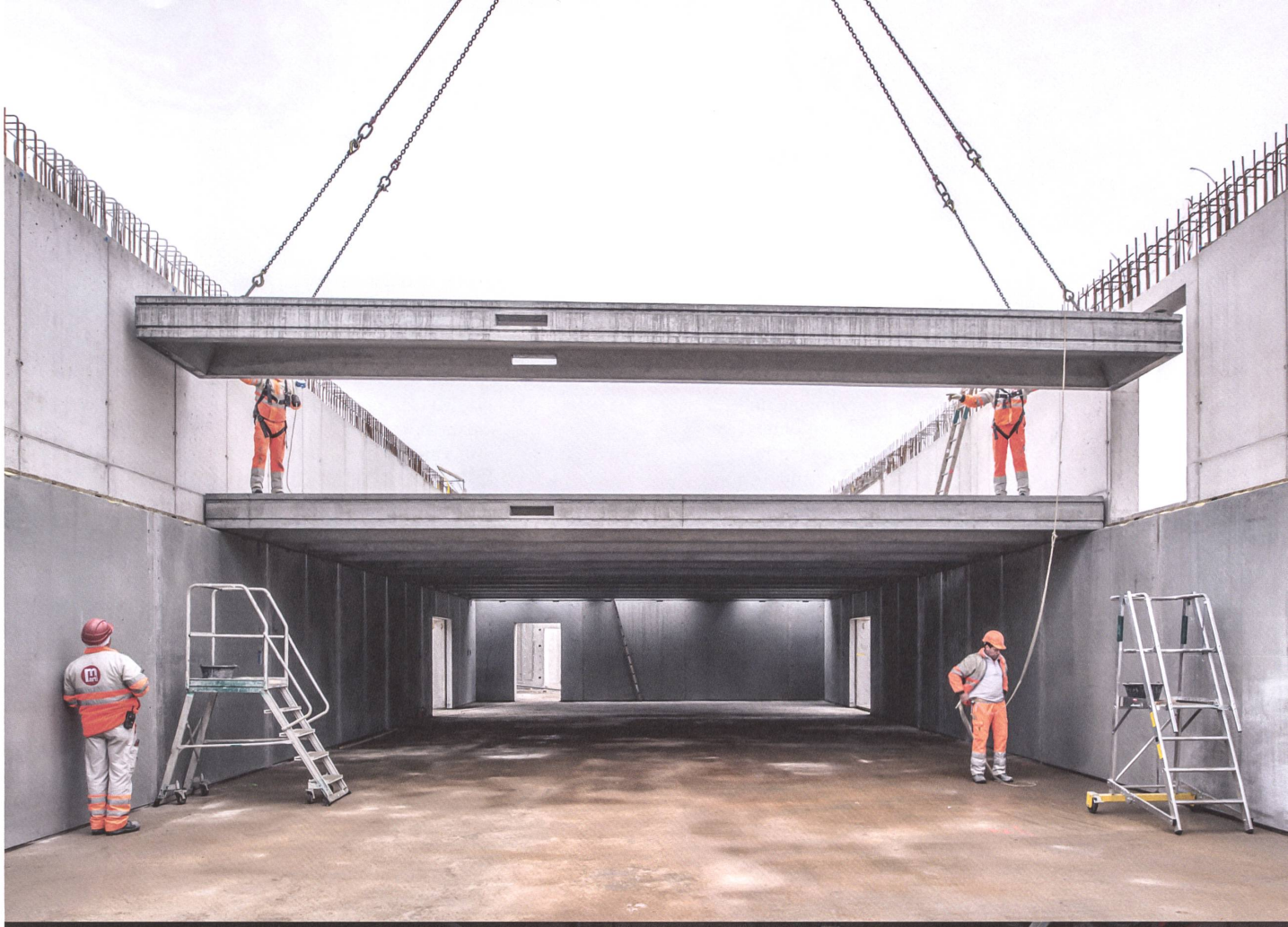
Versetzen von Deckenelementen Anfang 2018.
