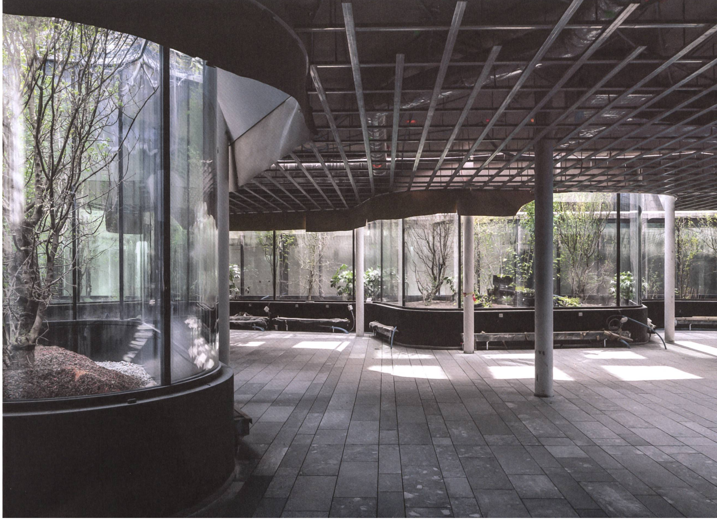
Personalrestaurant während dem Ausbau, 2021.
