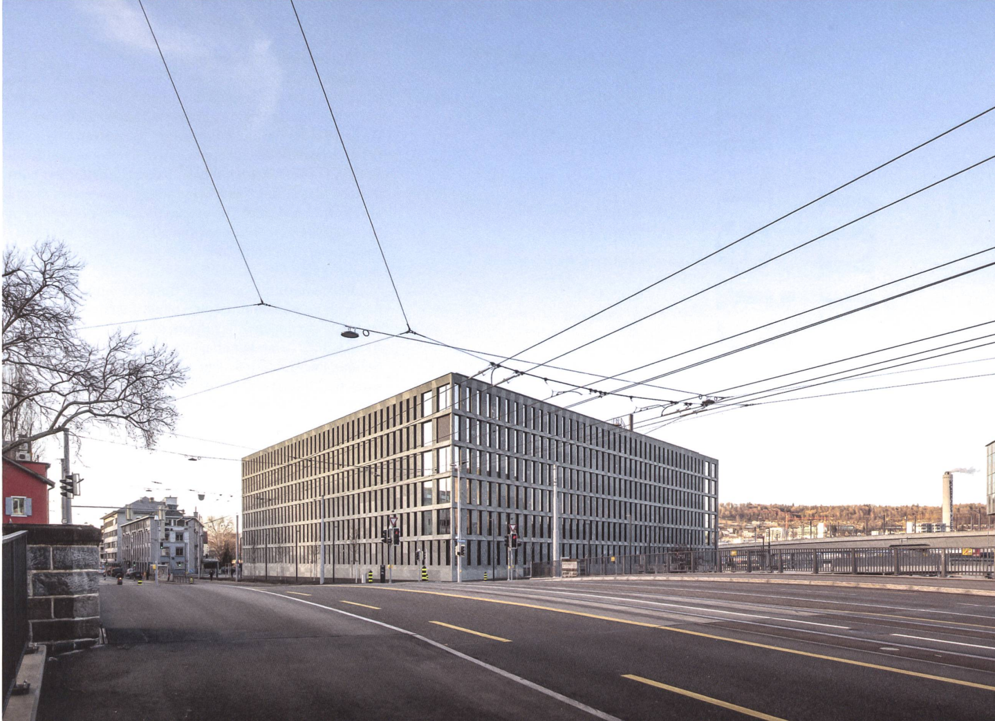
An der Hohlistrasse setzt sich das PJZ sechsgeschossig in Szene.
