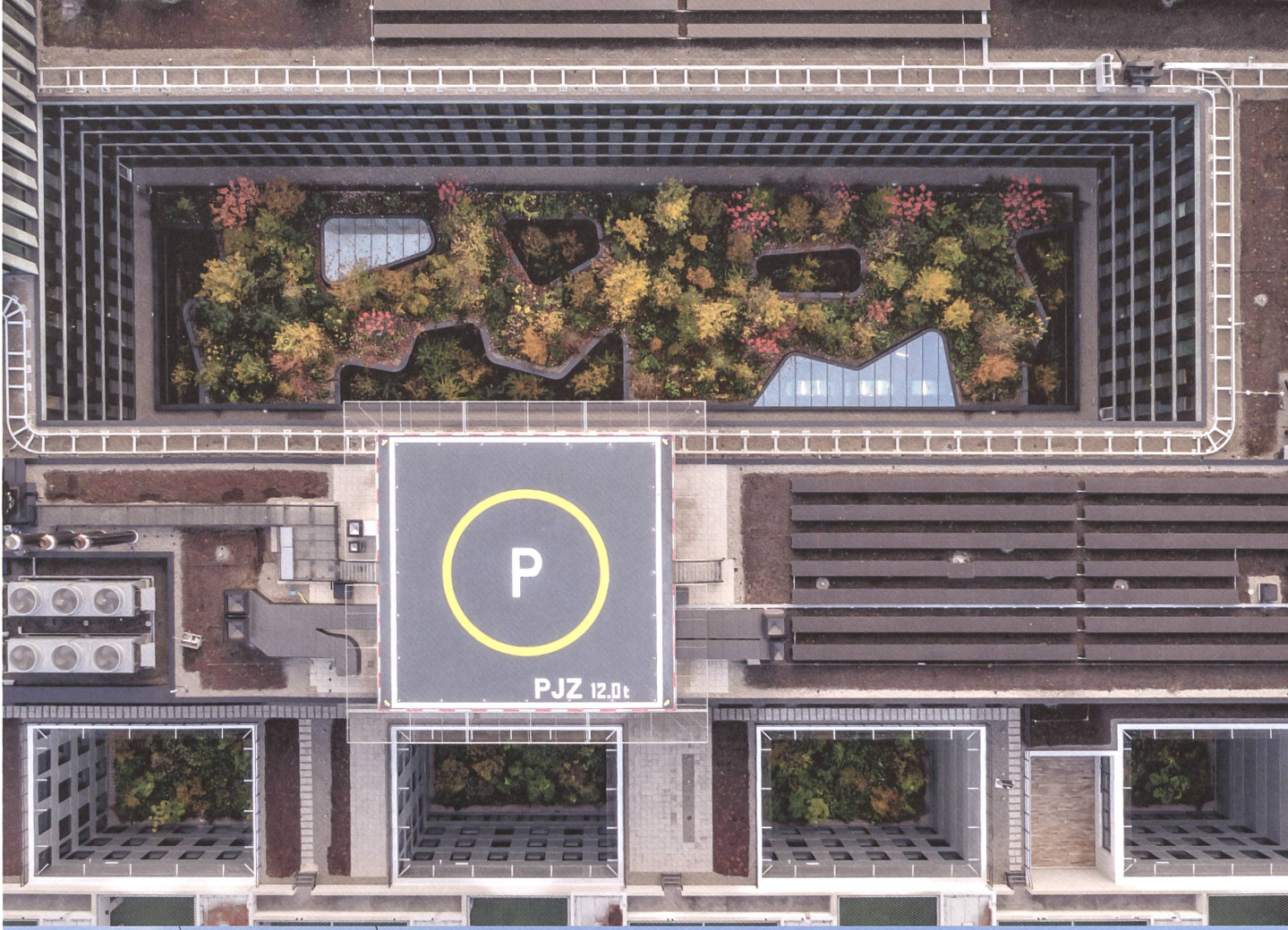
Die Drohnenaufnahme zeigt die Innenhöfe von Bürobereich und Gefängnis.
