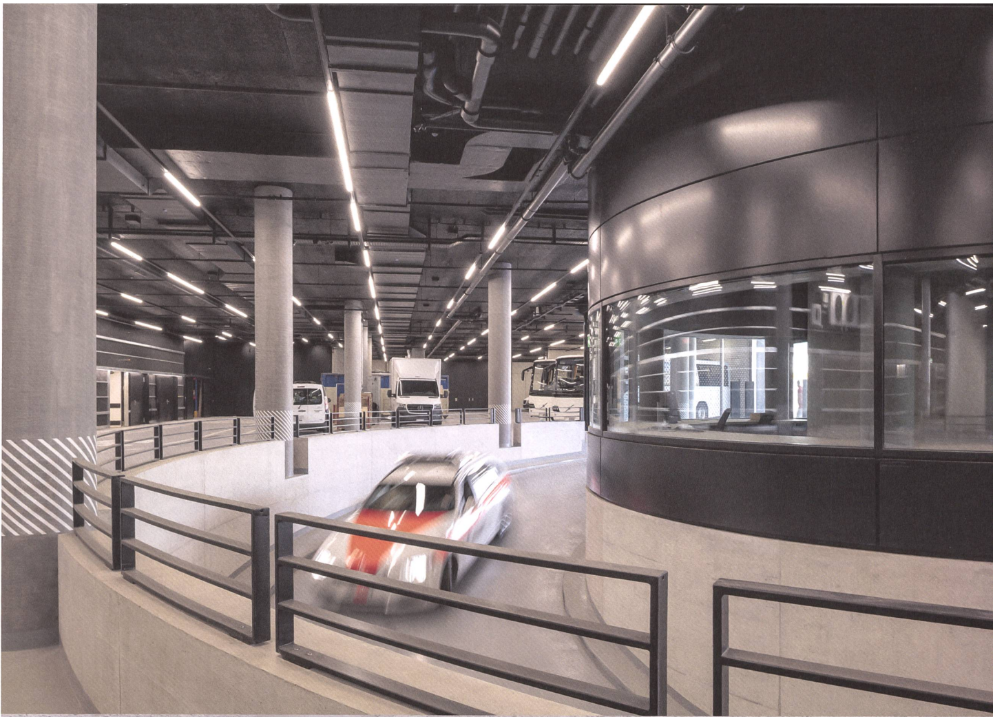
Die Anlieferung und die Zufahrt liegen an der Rückseite des Gebäudes.
