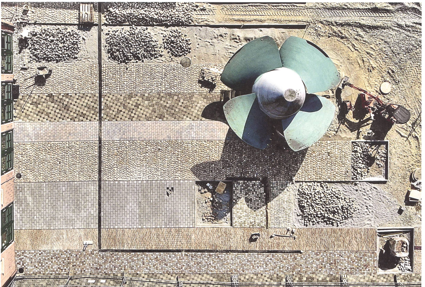
Echte Kreislaufwirtschaft: Auf dem Platz vor dem «Primeo Energie Kosmos» ist die unterschiedliche Herkunft der Steine und Betonstücke klar erkennbar. Foto: Jos. Schneider
