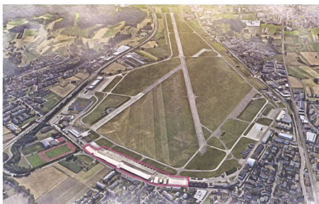
Etappe 1: Umbau der Bestandsbauten.
