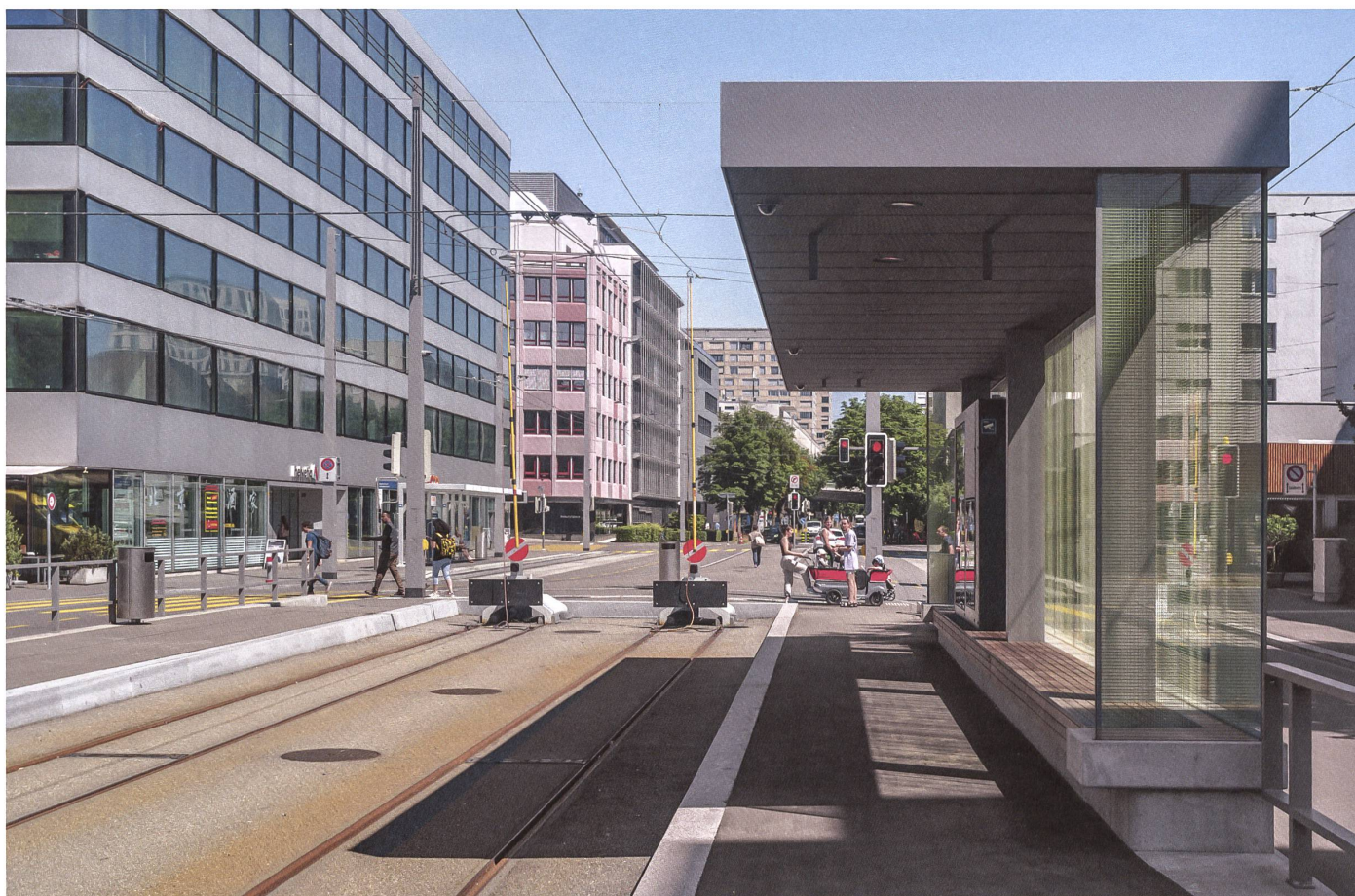
Zürich: Die Prellböcke am Bahnhof Altstetten markieren die Endhaltestelle. Wird das Trasse hier dereinst weitergeführt? Wer weiss! →
