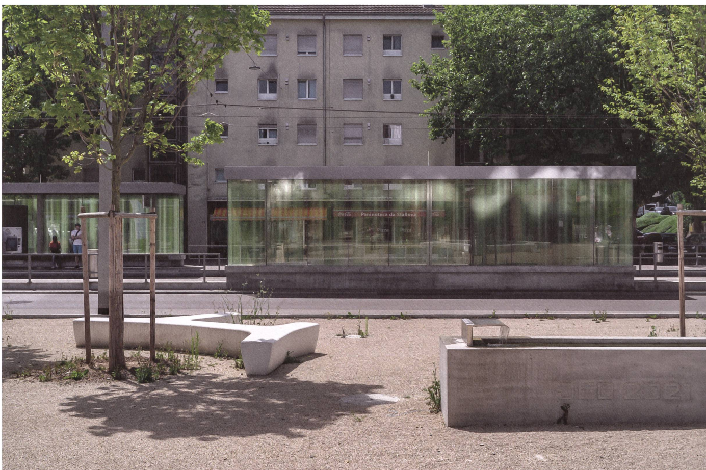
Schlieren: Bei der Haltestelle Wagonsfabrik schafft ein kleiner Park einen öffentlichen Freiraum. →
