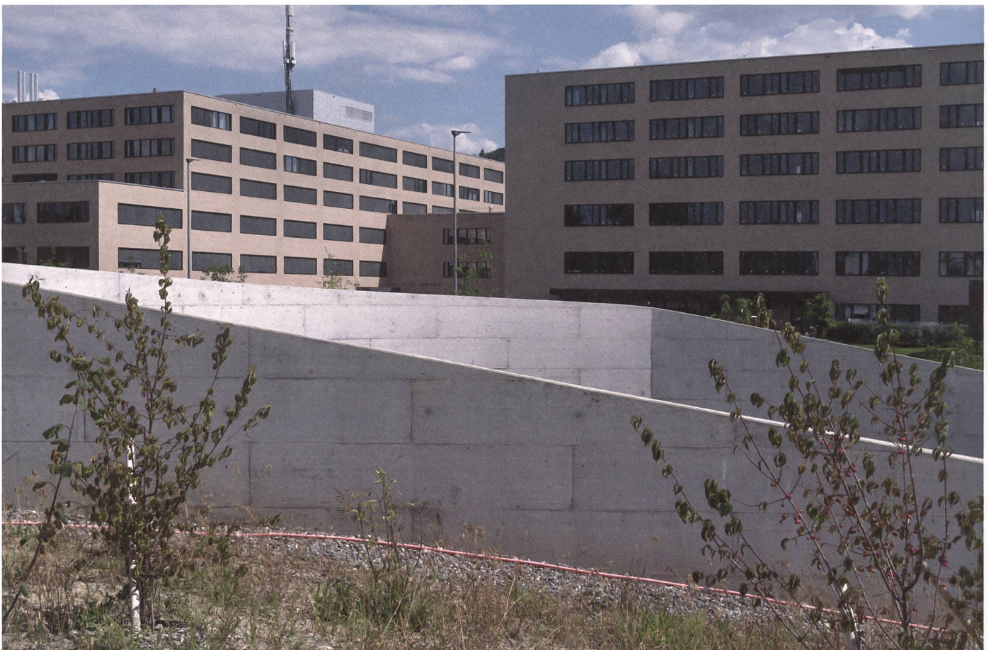
Schlieren: Auf der Südseite des Färberhüslitunnels ragen die Neubauten des Spitals Limmattal empor, das nun einen direkten Stadtbahnanschluss hat. →
