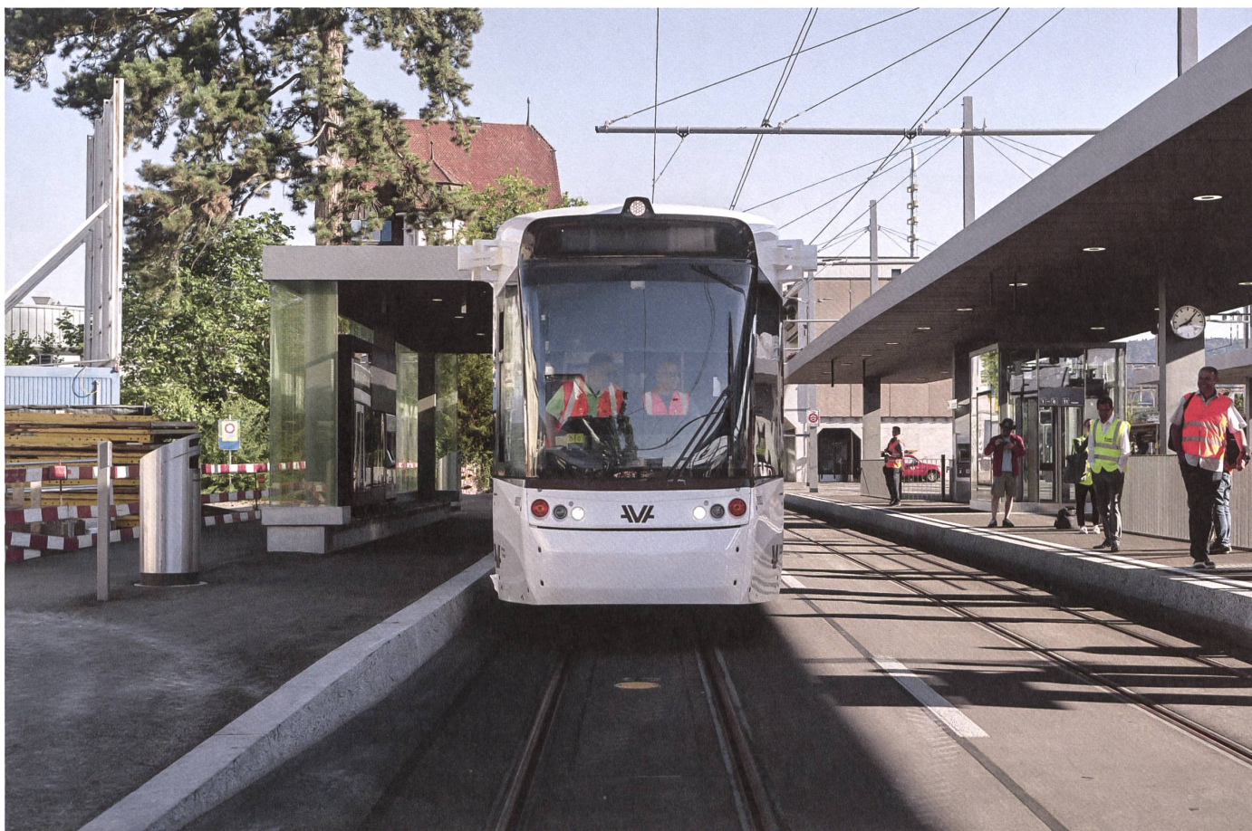
Dietikon: Das äusserste Perron folgt den Gestaltungsprinzipien der Limmattalbahn, die beiden grossen Dächer wurden davon abgeleitet. →
